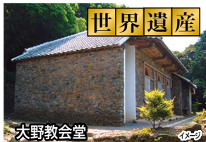
ド・ロ神父設計施工。外壁は地元の自然石を積み上げ、継目には独自の技法を用いた「ド・ロ壁」と呼ばれる。
