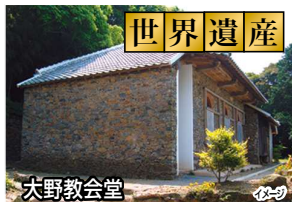
大野教会堂 ド・ロ神父設計施工。外壁は地元の自然石を積み上げ、総目には独自の技法を用いた「ド・ロ壁」と呼ばれる。
