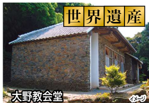
大野教会堂 ド・ロ神父設計施工。外壁は地元の自然石を積み上げ、窓には独自の技法を用いた「ド・ロ壁」と呼ばれる。
